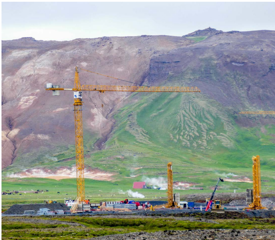
Ferðapjónusta á byggingartíma
